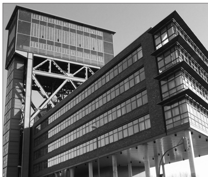
Der Gewerbepark rund um die Zeche Minister Stein steht für den erfolgreichen Strukturwandel. F: Annette Wardenbach
