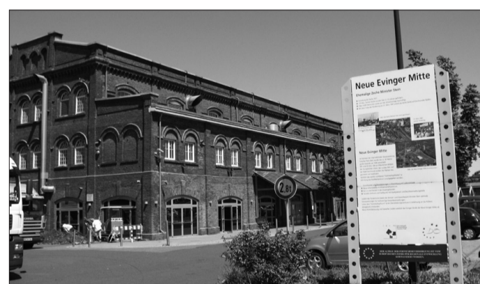
Die neue Evinger Mitte, ein gelungenes Beispiel für den Strukturwandel in Dortmund.
