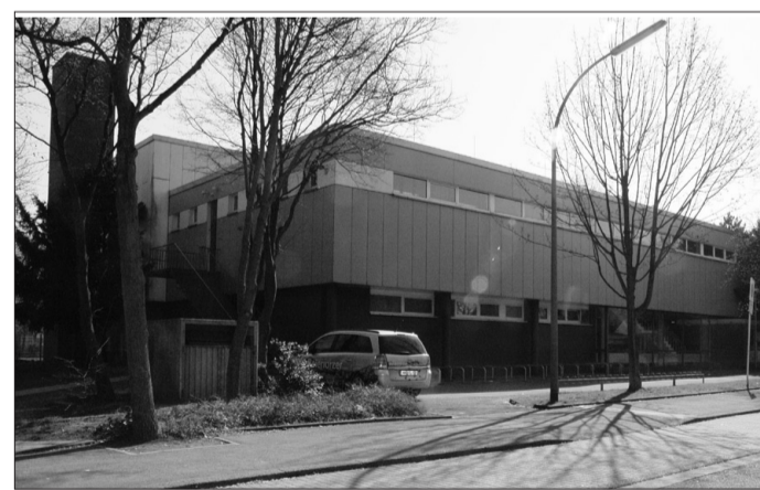
Mit 3 Mio. Euro wird die Sanierung des Bezirkshallenbades Nette ermöglicht. Foto: Steinhüser
